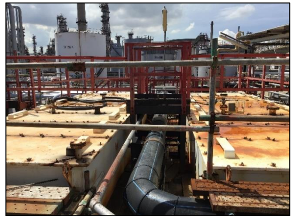
รูปที่ 2-8 ระบบ API Separator
